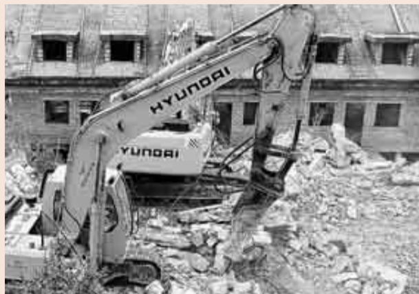
Las obras de demolición también exigen licencia.
